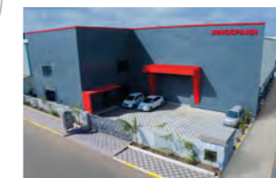
RINGSPANN Power Transmission India Pvt. Ltd., Indien
